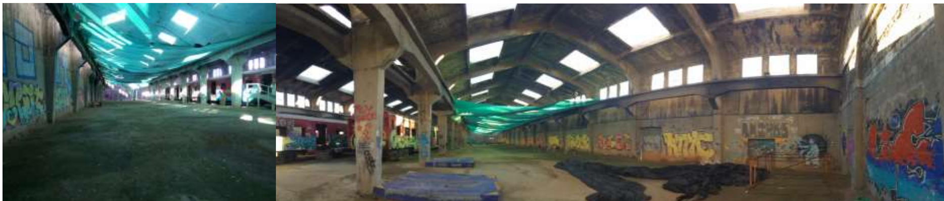
IMAGEN 13 ex sala de máquinas
