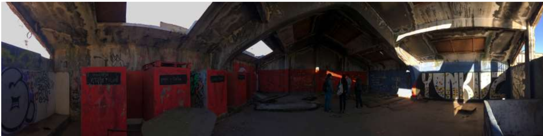
IMAGEN 14 bodega desocupada segundo piso
